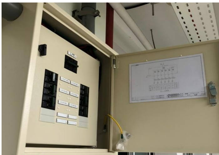
配電盤安裝完成
